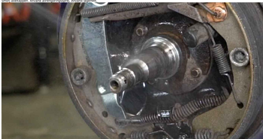
24 Installera bromstrumman som är monterad med hjulnavlagret.
